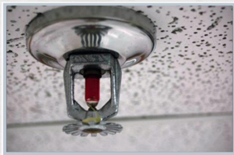
4 - Sprinklers sem oxidação nem sujeiras;
