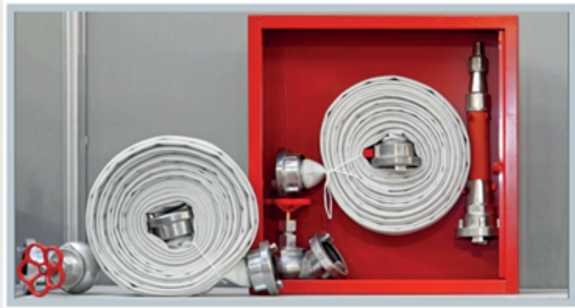
3 - Bombas de incêndio em manutenção periódica;
