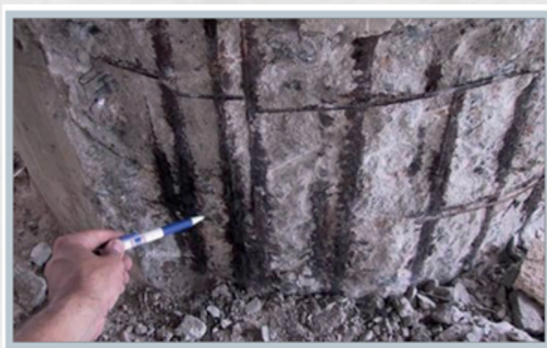
Viga com exposição de armaduras
