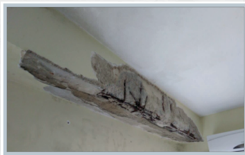
Viga com exposição de armaduras
